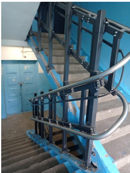
Установка подъемника в подъезде
