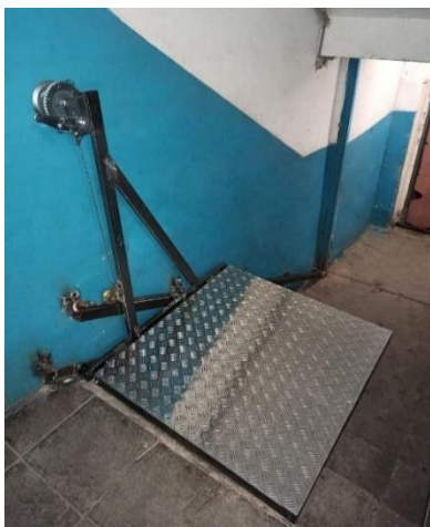
Установка подъемника в подъезде
